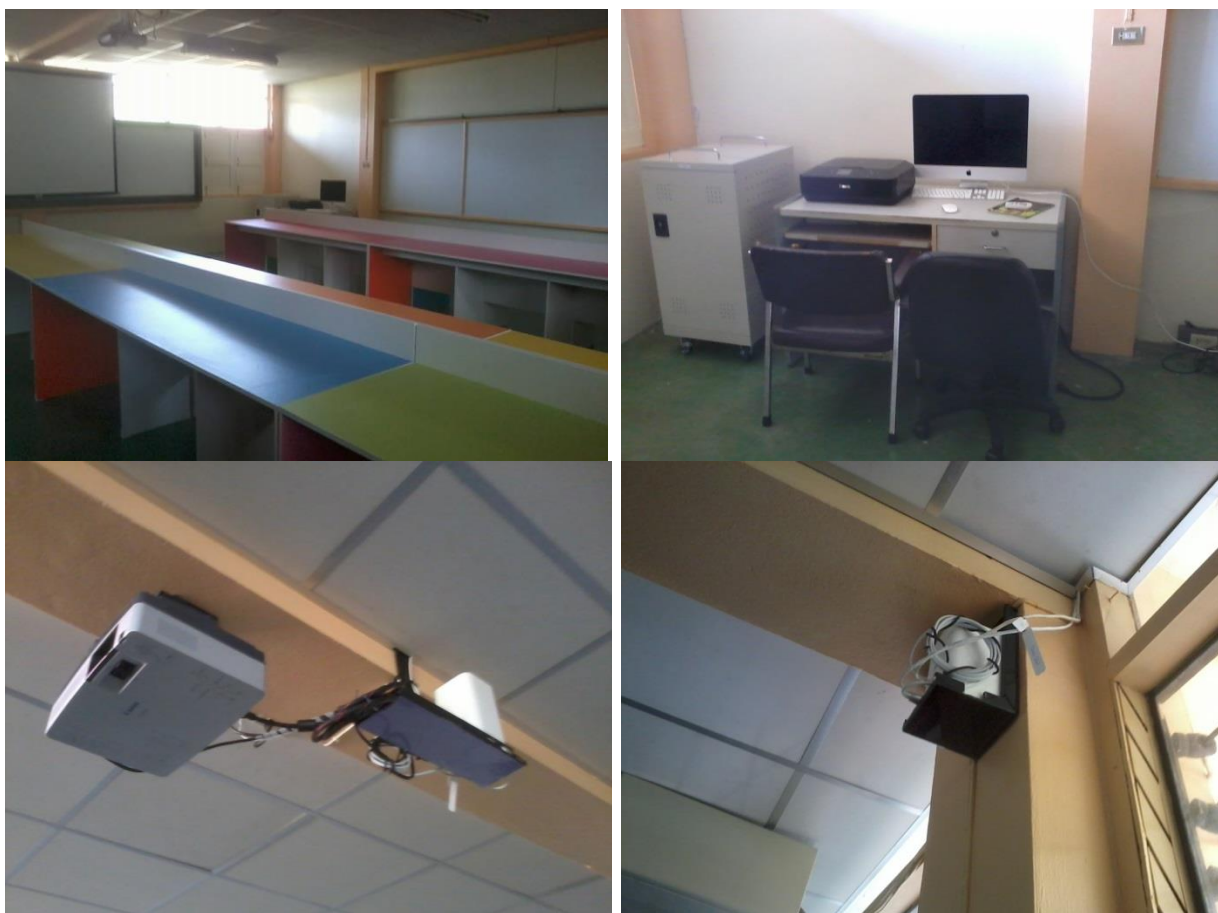
ภาพการติดตั้ง
