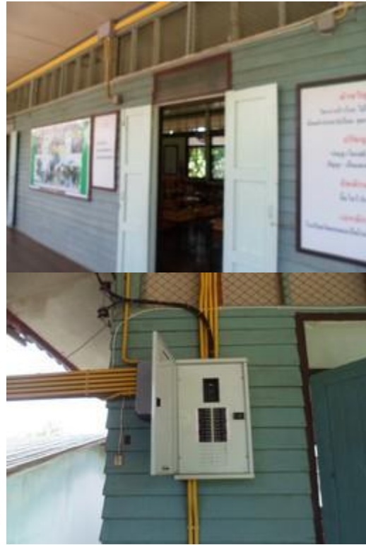
ภาพแผงควบคุมไฟฟ้า (Circuit Breaker) ของห้องที่จะใช้เป็นห้องเรียนคอมพิวเตอร์แท็บเล็ต
